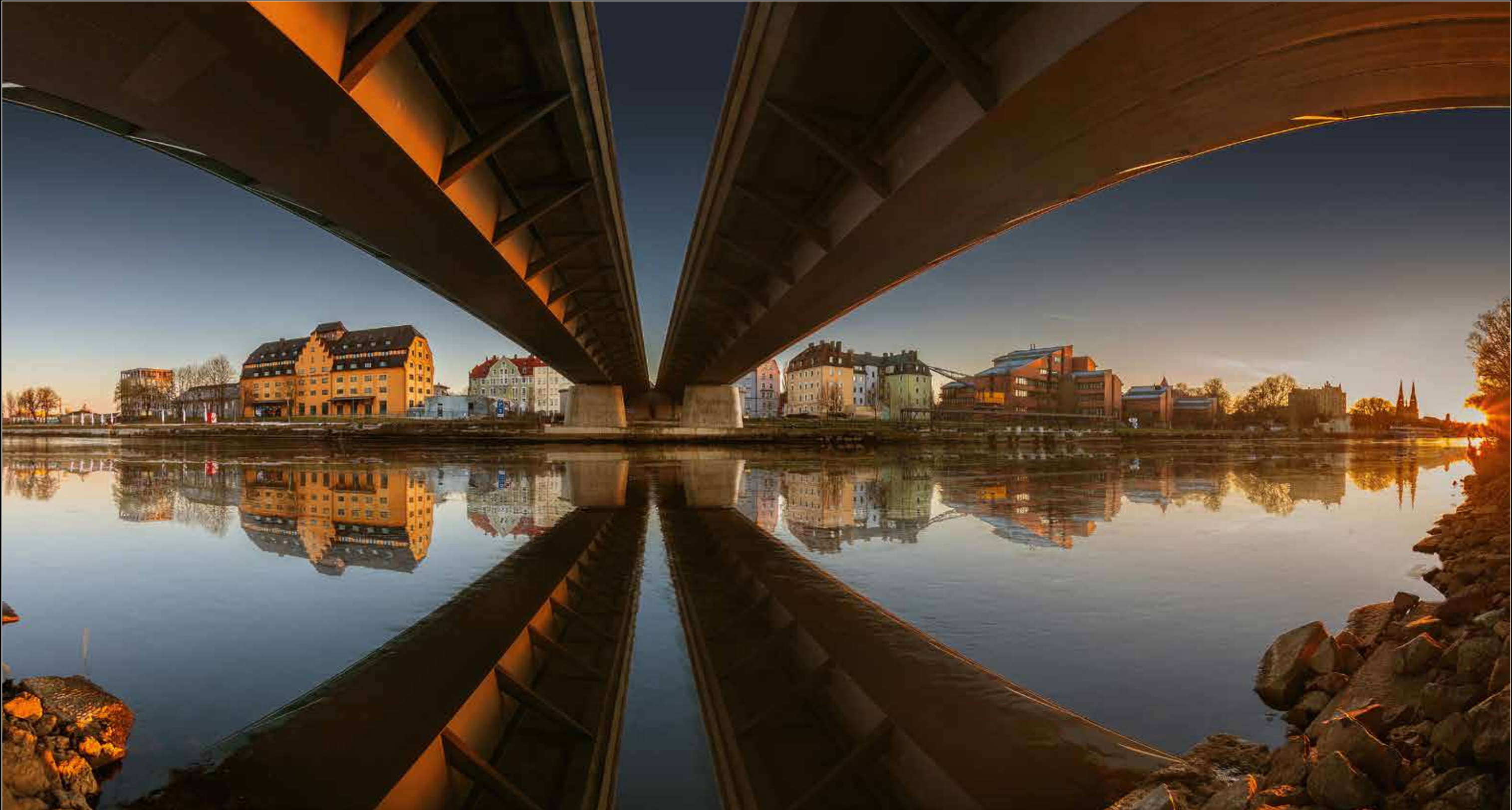
Unter der Nibelungenbrücke
